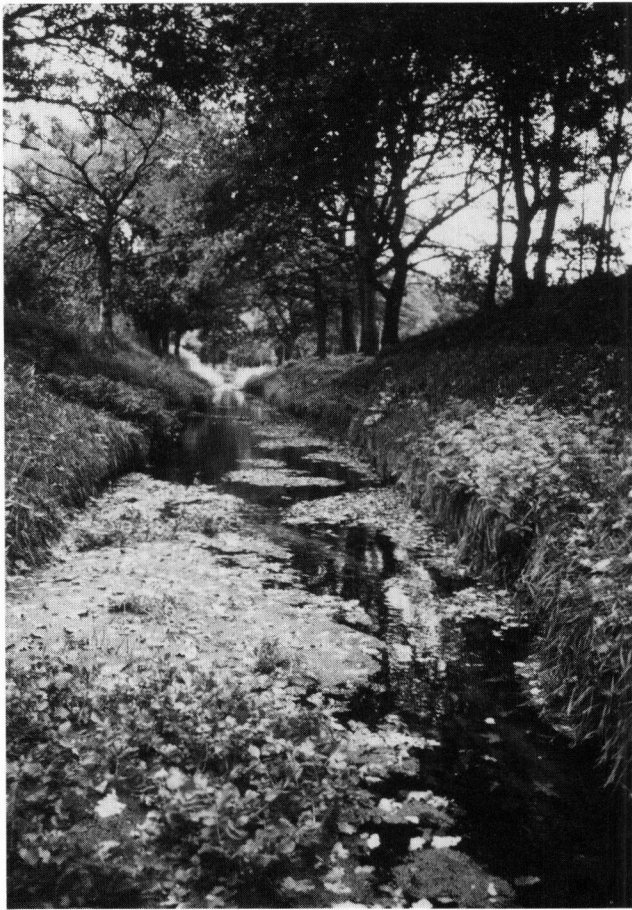
Figuur 4. De Oude Graaf: een nog niet gefileerd deel en een deel direct na het aanbrengen van het nieuwe oeverprofiel. Links met een mozaïekvormige vegetatie en gevarieerde oevers op het nog niet gefileerde deel en rechts direct na het aanbrengen van het nieuwe oeverprofiel waarover in de toekomst nog zand wordt gestort waardoor echter vrij eenvormige oevers zullen overblijven.
